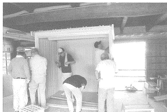
各地区の皆さんでの設置作業
